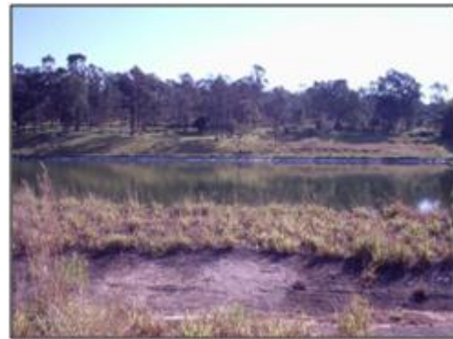
Figura 2 – Vista da lagoa facultativa primária
