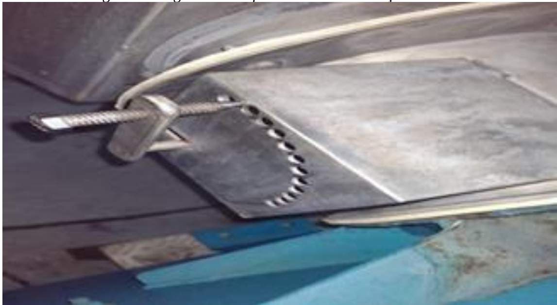
Figura 2. Imagem do Dumper antes da modificação realizada.
